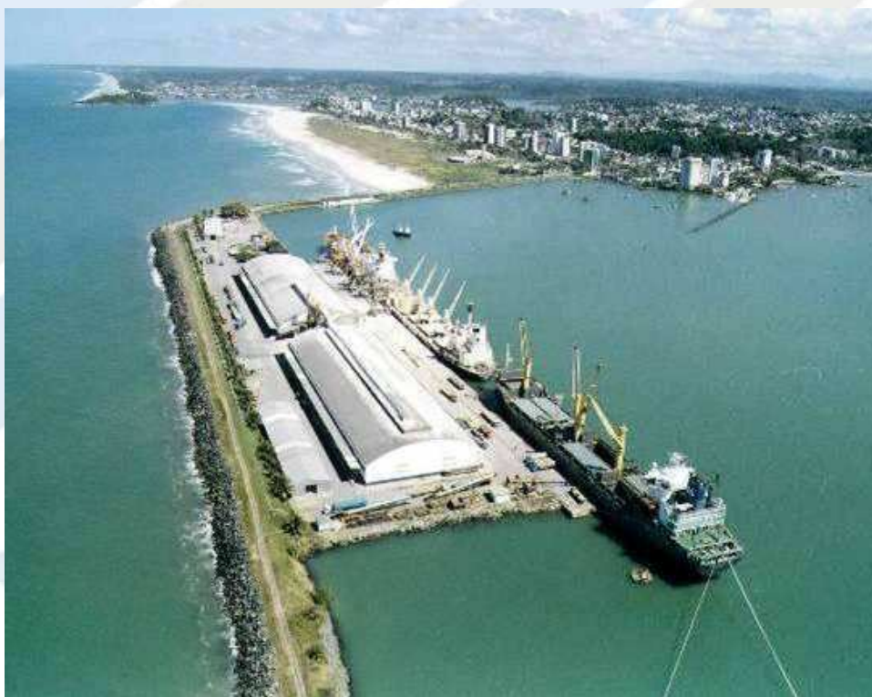
Figura 7 - Vista Aerea do Porto de Ilhéus
