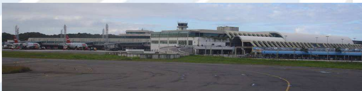
Figura 4 - Vista Parcial do Aeroporto Internacional Deputado Luís Eduardo Magalhães
